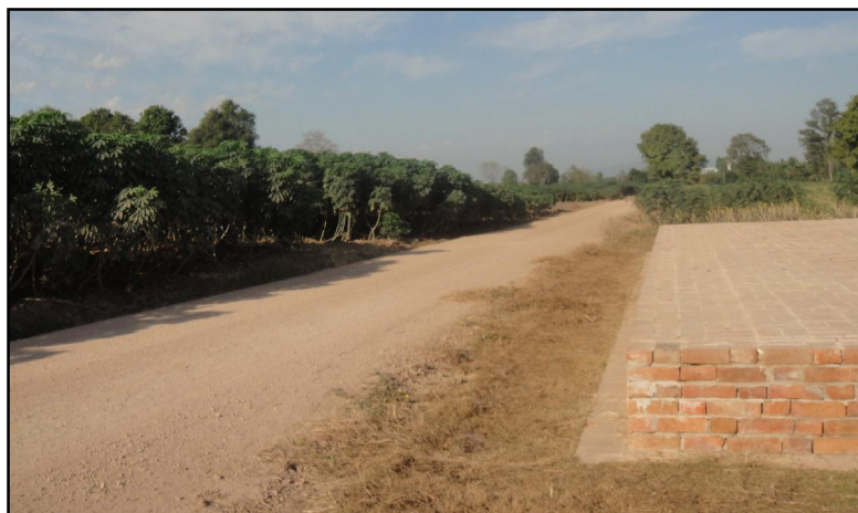
ภาพที่ ๓.๑๗ สภาพถนนลูกรังที่เข้าสู่โบราณสถานเมืองไทรตรังซ์หลังปรับปรุงทัศน พ.ศ.๒๕๕๘
