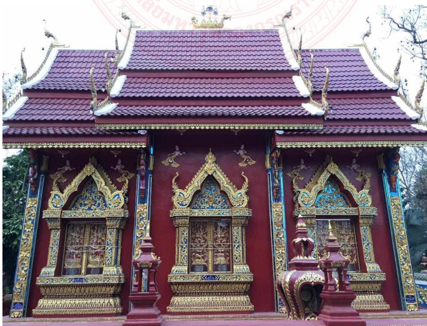
ภาพที่: ๔.๑ ภาพด้านนอกอุโบสถ ใช้นาคทนต์ติดตั้งเสริมอาคาร
