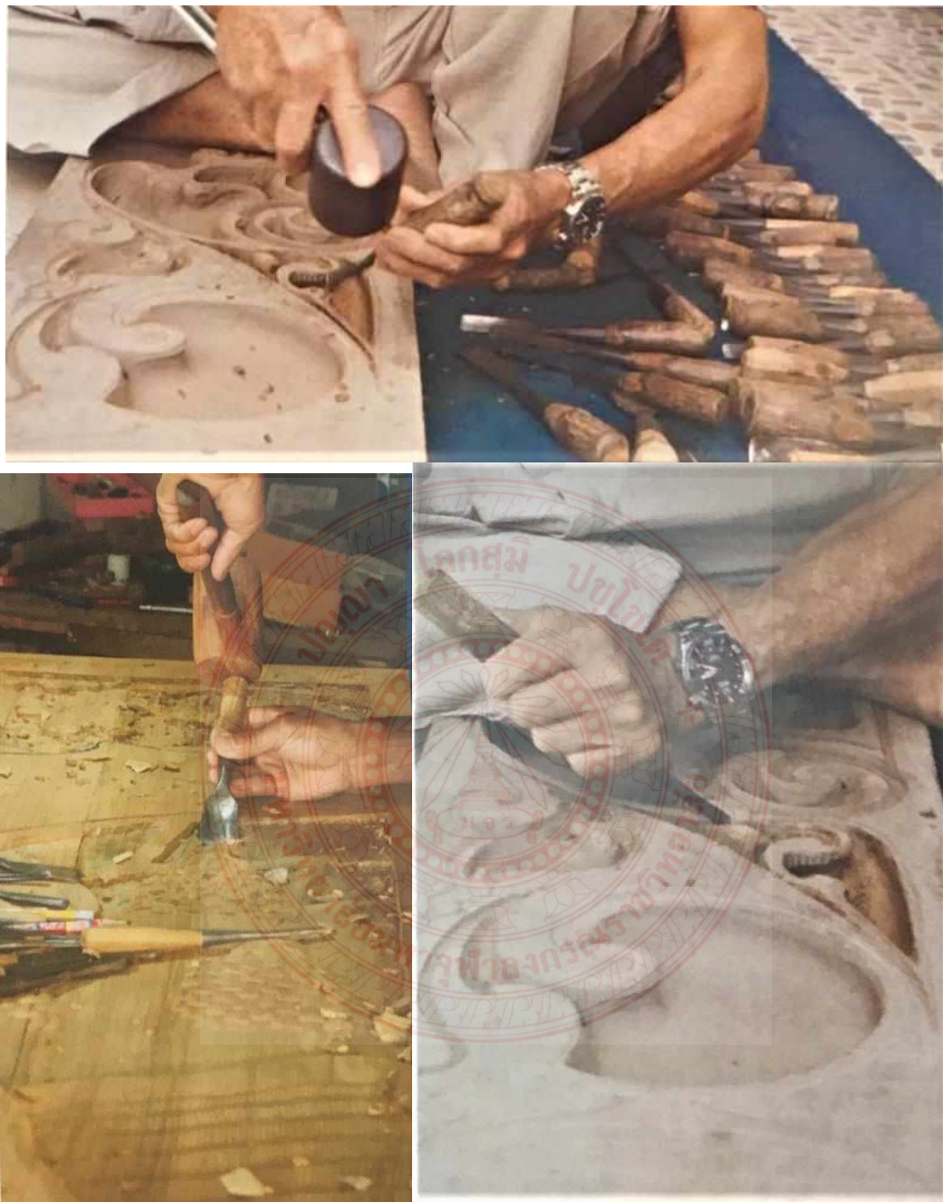
ภาพที่: ๔.๒๖ การสกัด แกะเซาะร่องไม้ ให้เป็นไปตามรูปทรงที่กำหนดไว้
