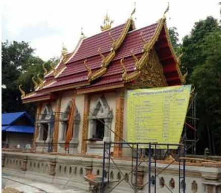
ภาพที่: ๔.๒ ภาพอุโบสถที่อยู่ระหว่างการบูรณะ แล้ว
