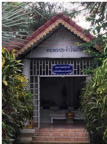
ภาพที่: ๔.๔ หอพระประจำวันเกิด (อาคารใช้เก็บนาคนันต์)
