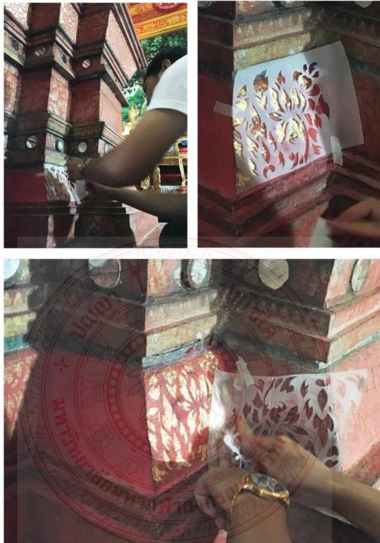
ภาพที่: ๔.๗๔ จากนั้นลงกาวยประสานเพื่อจะได้นำทองมาปิด ด้วยยางมะเดื่อและนำกระดาษไขที่ฉลุ มาติดลงกับฐานธรรมาสน์ส่วนที่เป็นบัวคว่ำแล้วนำ ทองคำเปลวมาปิดลงให้เต็ม
