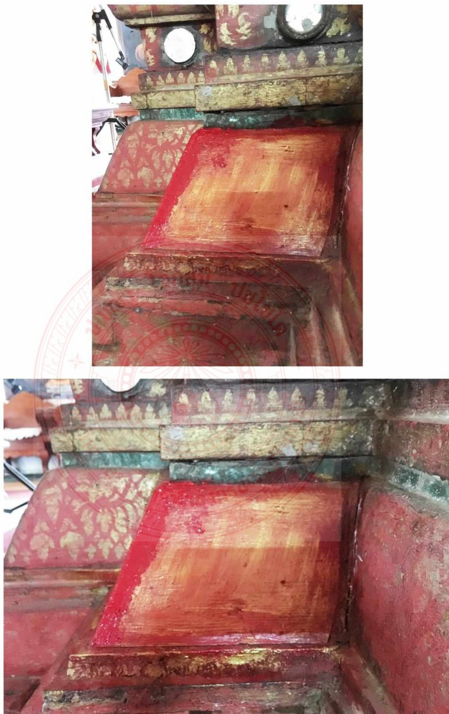
ภาพที่: ๔.๖๘ เราจะทำการอุดช่องว่าง บริเวณพื้นผิวที่ไม่สม่ำเสมอและรองกว่าสีที่อุดเอาไว้แห้งจากนั้นจะทำการขัดโดยใช้ กระดาษทรายเบอร์ละเอียดขัดให้พื้นเรียบง่ายต่อการทำงาน
