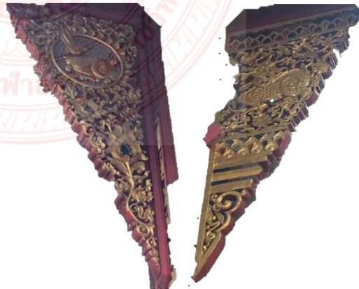
ภาพที่: ๔.๑๔ ภาพนาคันทน์ที่เป็นส่วนประกอบอาคารอุโบสถวัดมิ่งเมือง
