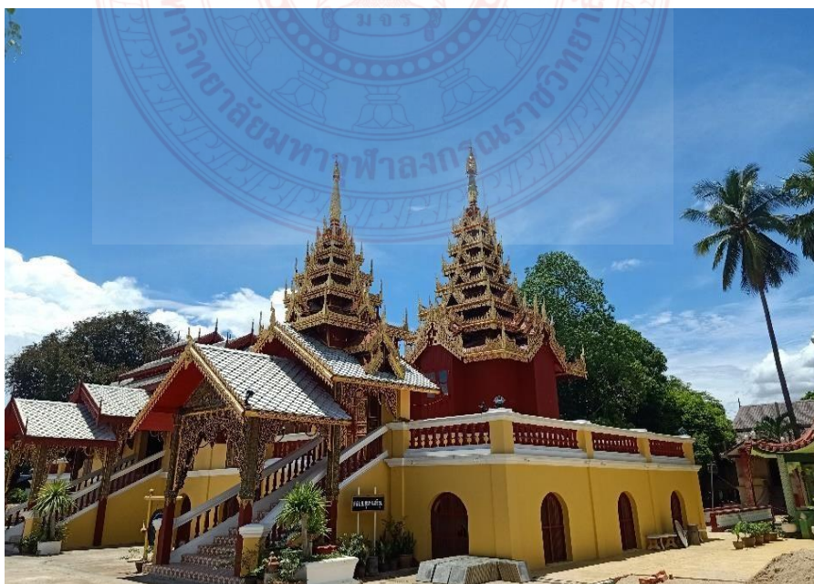
แผนภาพที่ ๔.๑๒. พระวิหารมีลักษณะตึกครึ่งไม้แบบพม่า มีหลังคาซ้อนกันหลายชั้น แต่ละชั้นลดหลั่นกันถึง ๗ ชั้น ขึ้นไปหาเรือนยอด ชั้นบนสุดประดับด้วยฉัตรทองคำตัวพระวิหารมีมุขบันไดทางขึ้นทั้งสองด้าน
