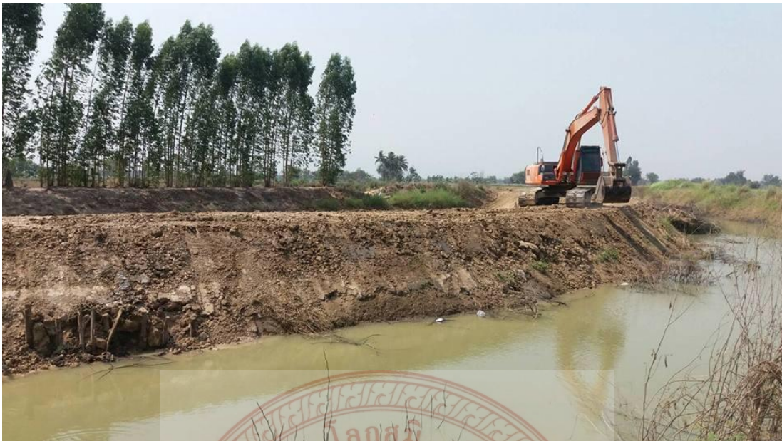
แผนภาพที่ ๔.๘ สภาพการขุดลอกคูคลองในพื้นที่ลำน้ำแม่วงศ์
