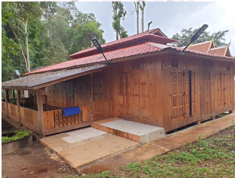
ภาพที่ 4.70 อาคารเรือนที่พัก
