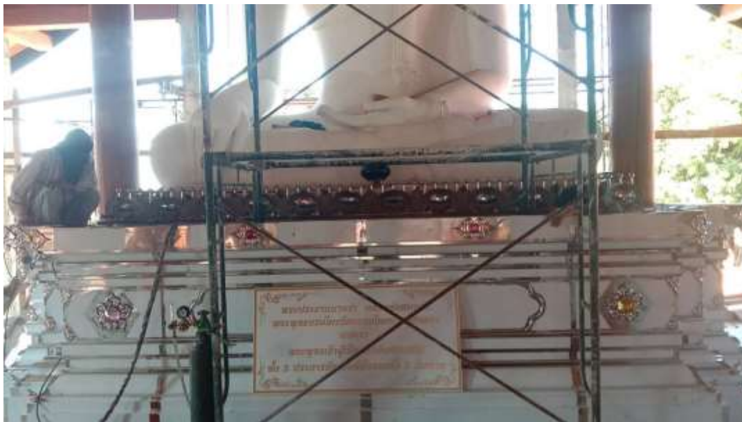
ภาพที่ ๒๐ การติดตั้งชิ้นงานบัวรองรับฐานทั้งหมดรอบฐานองค์พระพุทธรูปประธานวัดสามขา
