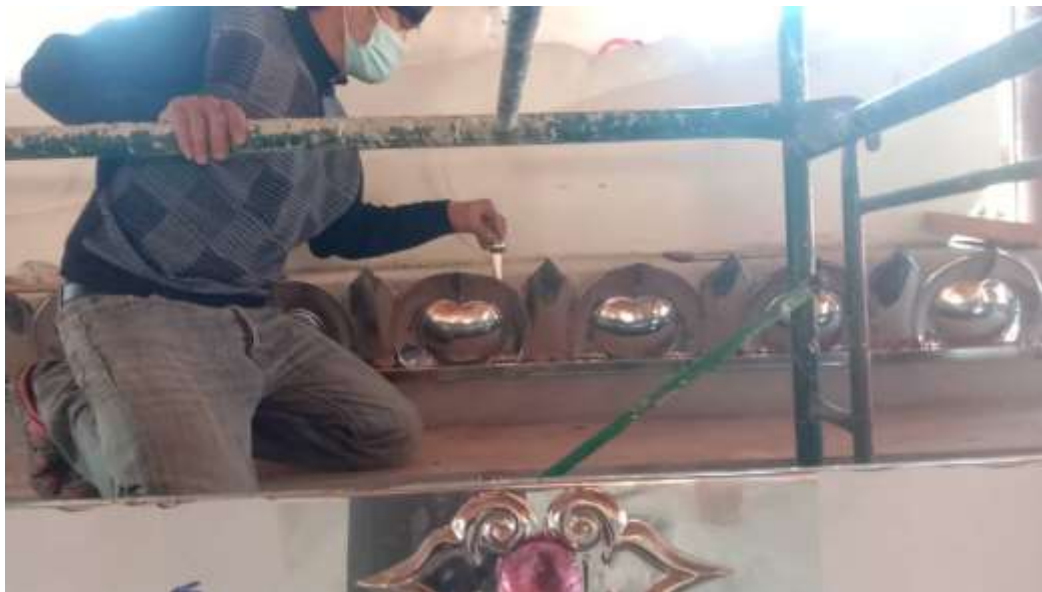
ภาพที่ ๑๔ การติดตั้งชิ้นงานลวดลายพุทธศิลปกรรมล้านนาแบบบัวพินัยักษ์
