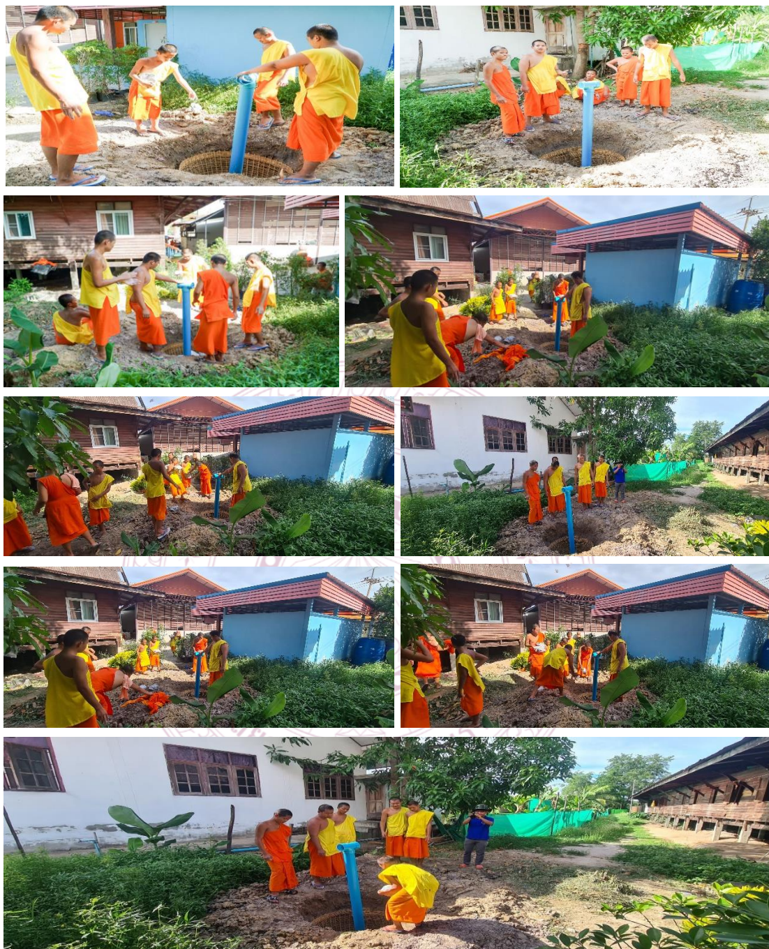
แผนภาพที่ ๔.๑๕ การจัดทำธนาคารน้ำใต้ดินแบบพอเพียงระบบปิด แบบคร้วเรือน บริเวณวัดหนองกระดุกเนื้อ
