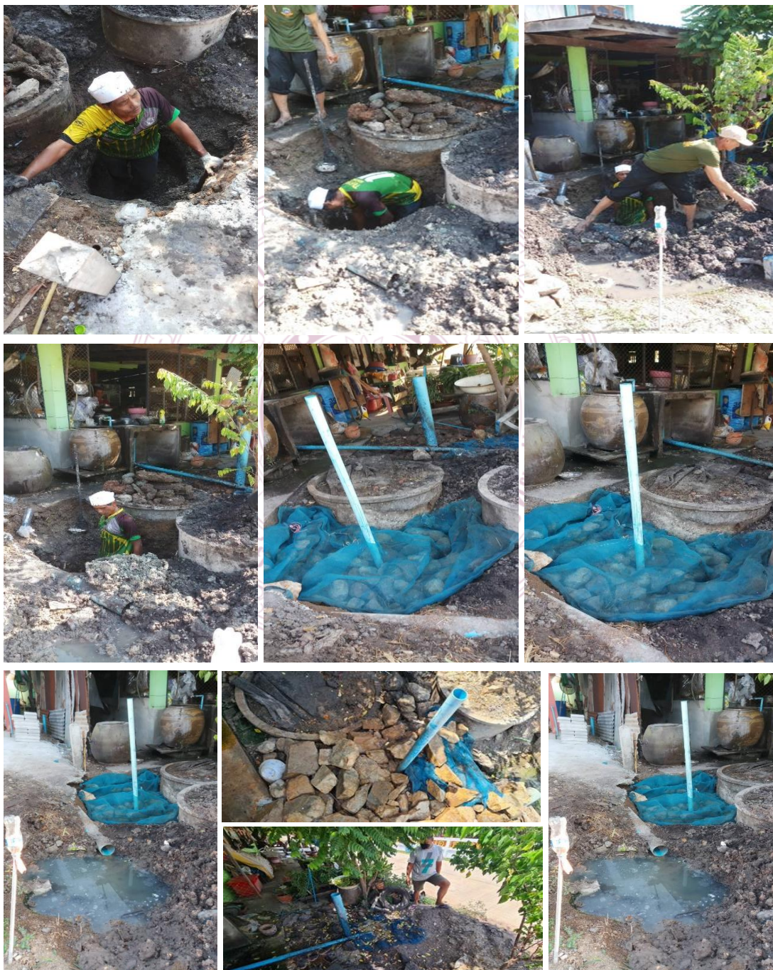
แผนภาพที่ ๔.๑๘ การจัดทำธนาคารน้ำใต้ดินแบบพอเพียงระบบปิด บริเวณร้านก๋วยเตี๋ยวบ้านหัวถนนกลาง
