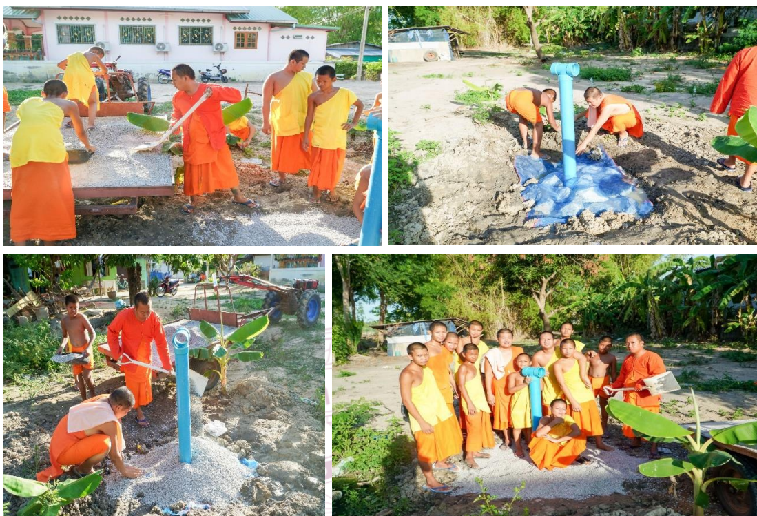
แผนภาพที่ ๔.๑๖ การจัดทำธนาคารน้ำใต้ดินแบบพอเพียงระบบปิด แบบคร้วเรือน บ้านหนองกระดุกเนื้อ
