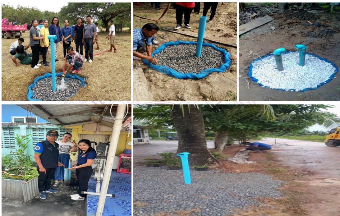
แผนภาพ ๔.๓ การจัดทำธนาคารน้ำใต้ดินแบบพอยท์ระบบปิดแบบครัวเรือนและระบบรางไรท่อ สำหรับกรณีน้ำท่วมขังผิวการจราจรในพื้นที่ตำบลกลางแดด
