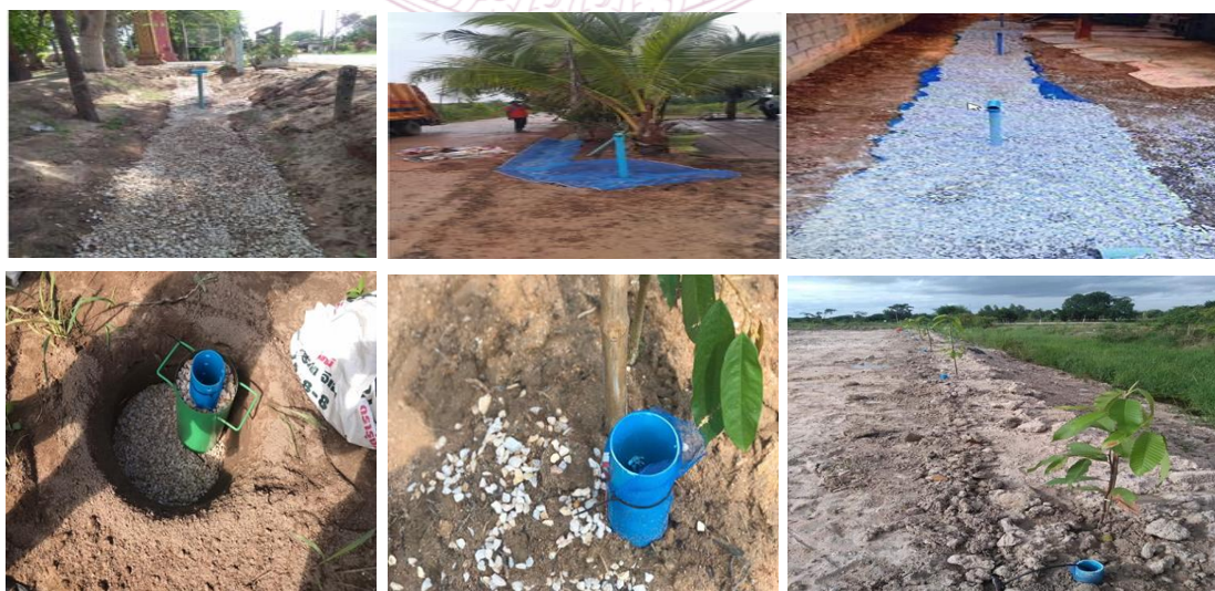
แผนภาพที่ ๔.๙ ธนาคารน้ำใต้ดินระบบปิดแบบรางไรท่อของเทศบาลตำบลหนองมะโมง
