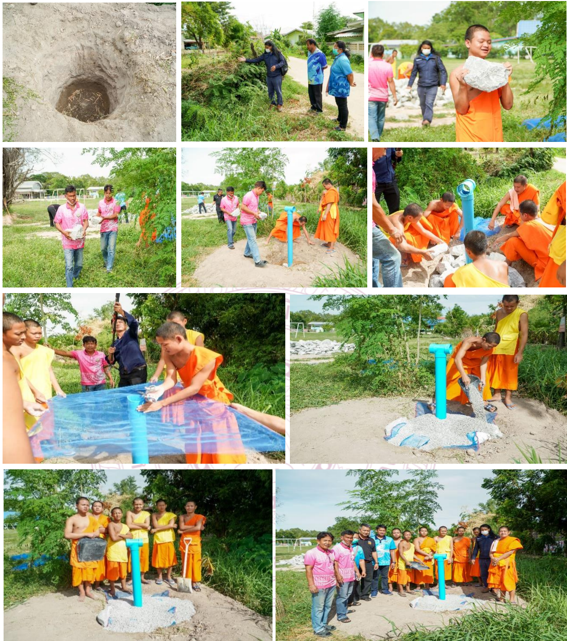
แผนภาพที่ ๔.๑๔ การจัดทำธนาคารน้ำใต้ดินแบบพอเพียงระบบปิด แบบคร้วเรือน บริเวณปากคลอง กลางชุมชนบ้านหนองกระดุกเนื้อ
