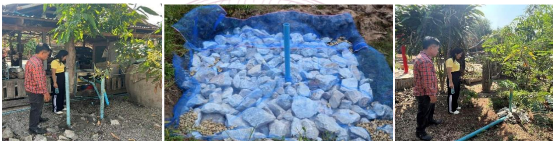
แผนภาพที่ ๔.๘ ธนาคารน้ำใต้ดินระบบปิดแบบครัวเรือนของเทศบาลตำบลหนองมะโมง
