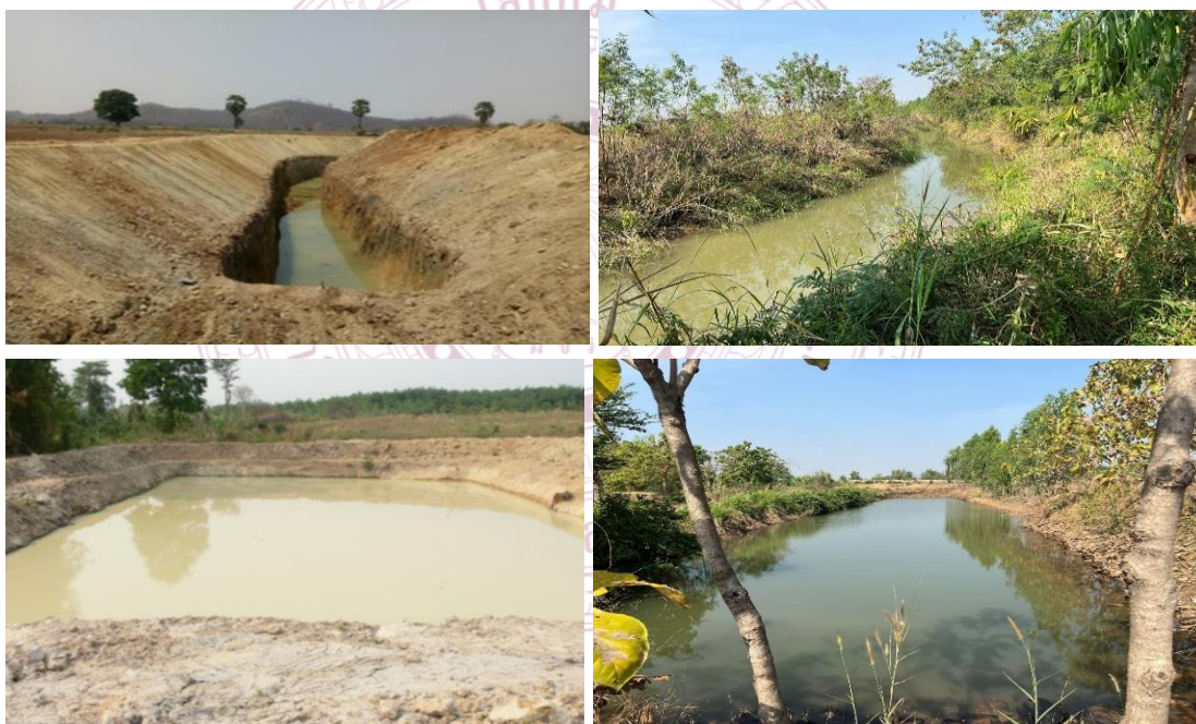
แผนภาพที่ ๔.๑๐ ธนาคารน้ำใต้ดินระบบเปิดแบบคลองสาธารณะและแบบสระน้ำ
