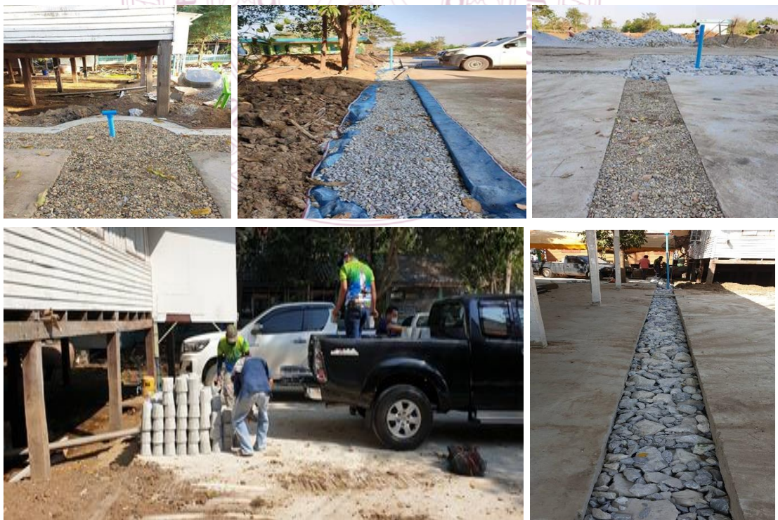
แผนภาพที่ ๔.๑ การประยุกต์ใช้ธนาคารน้ำใต้ดินแบบพอเพียงระบบปิดแบบรางไรท่อมาแก้ไขปัญหาเรื่องน้ำท่วมขังบริเวณกุฏิและศาลาการเปรียญที่วัดห้วยด้วน
