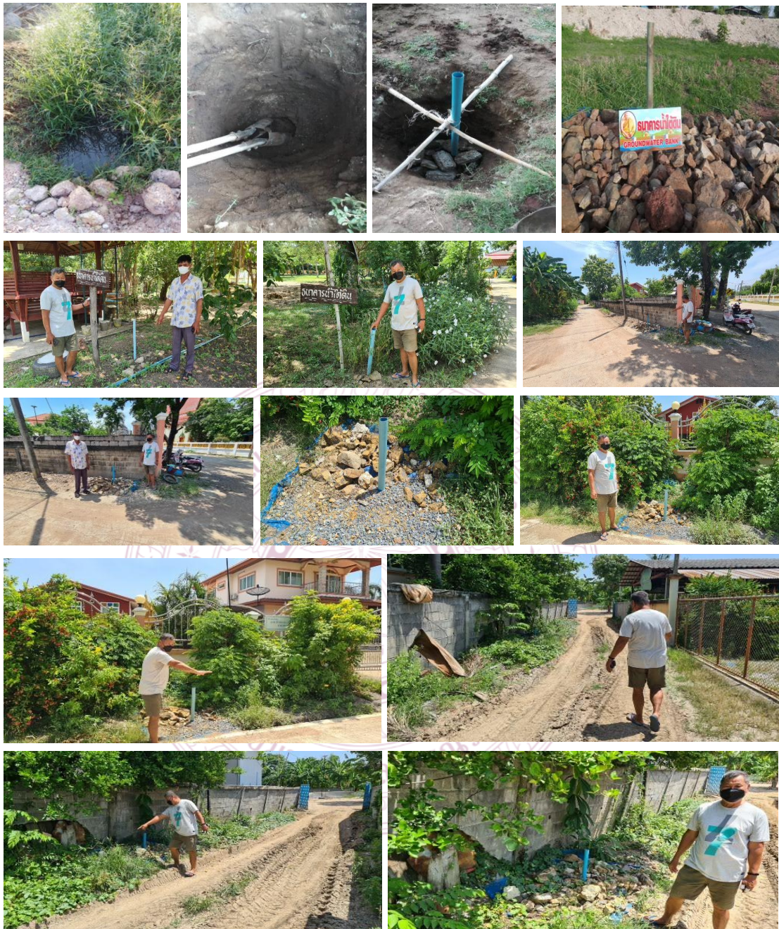
แผนภาพที่ ๔.๑๗ การจัดทำธนาคารน้ำใต้ดินแบบพอเพียงระบบปิด แบบครัวเรือน บ้านหัวถนนกลาง ในจุดต่าง ๆ ที่มีปัญหาน้ำท่วมขังในชุมชนและภายในวัดหัวถนนกลาง
