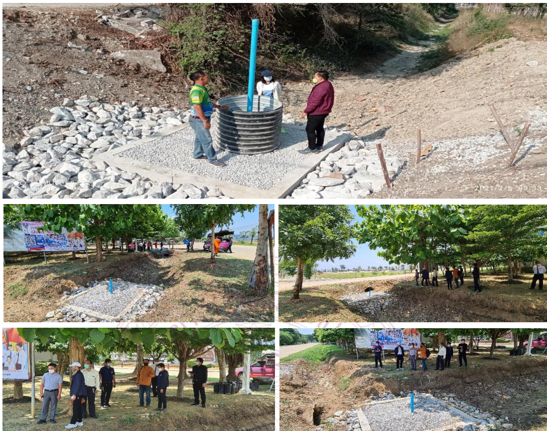
ภาพที่ ๔.๗ การพัฒนาฐานการเรียนรู้ธนาคารน้ำใต้ดินแบบพอเพียงระบบเปิดชนิดลำห้วยโดยพัฒนาจากคลองไส้ไก่
