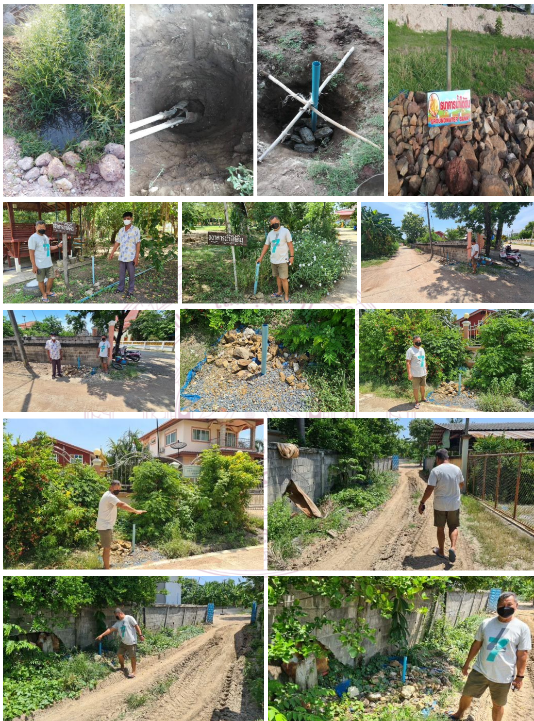
ภาพที่ ๔.๑๐ การจัดทำธนาคารน้ำใต้ดินแบบพอเพียงระบบปิด แบบคร้วเรือน บ้านหัวถนนกลาง ในจุดต่าง ๆ ที่มีปัญหาน้ำท่วมขังในชุมชนและภายในวัดหัวถนนกลาง
