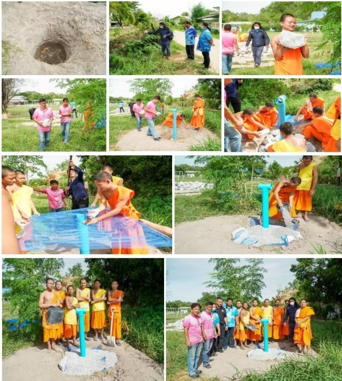
ภาพกิจกรรม การจัดทำธนาคารน้ำใต้ดินแบบพอเพียงระบบปิด แบบครัวเรือน บริเวณปากคลองกลางชุมชนบ้านหนองกระดุกเนื้อ
