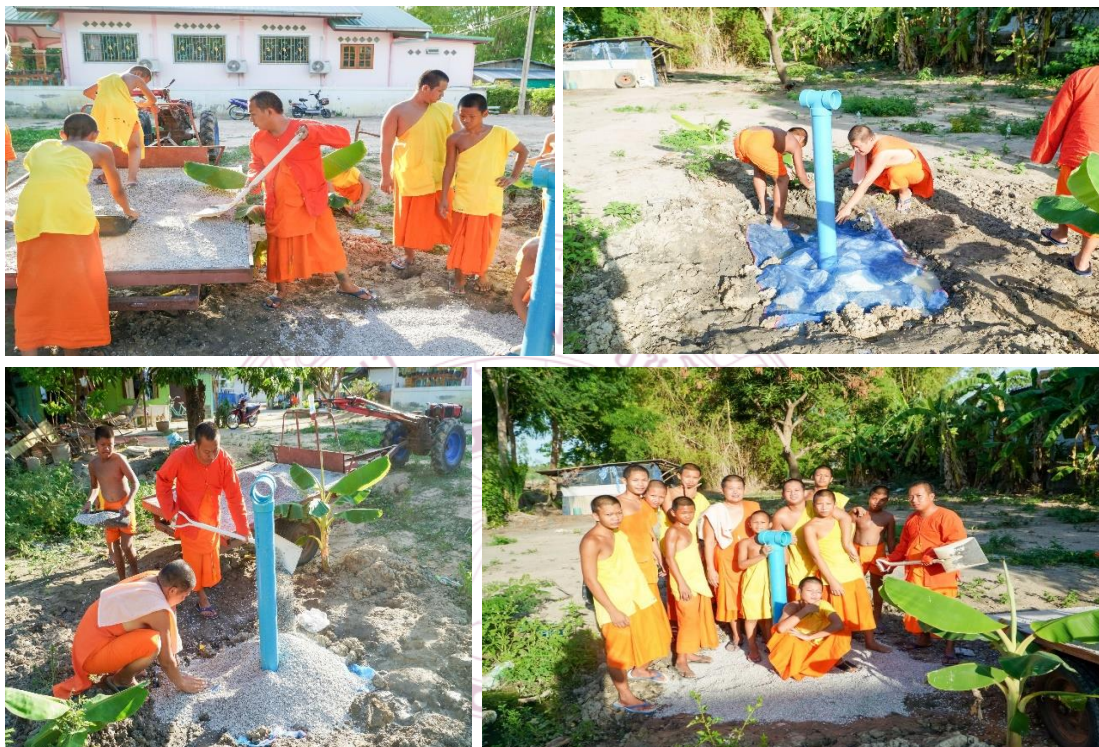
ภาพที่ ๔.๙ การจัดทำธนาคารน้ำใต้ดินแบบพอเพียงระบบปิด แบบคร้วเรือน บ้านหนองกระดุกเนื้อ
