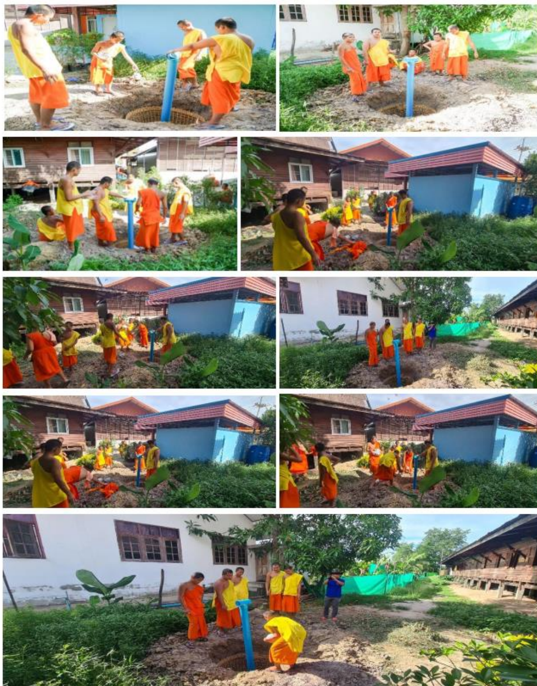
ภาพกิจกรรม การจัดทำธนาคารน้ำใต้ดินแบบพอเพียงระบบปิด แบบคร้วเรือน บริเวณวัดหนองกระดุกเนื้อ
