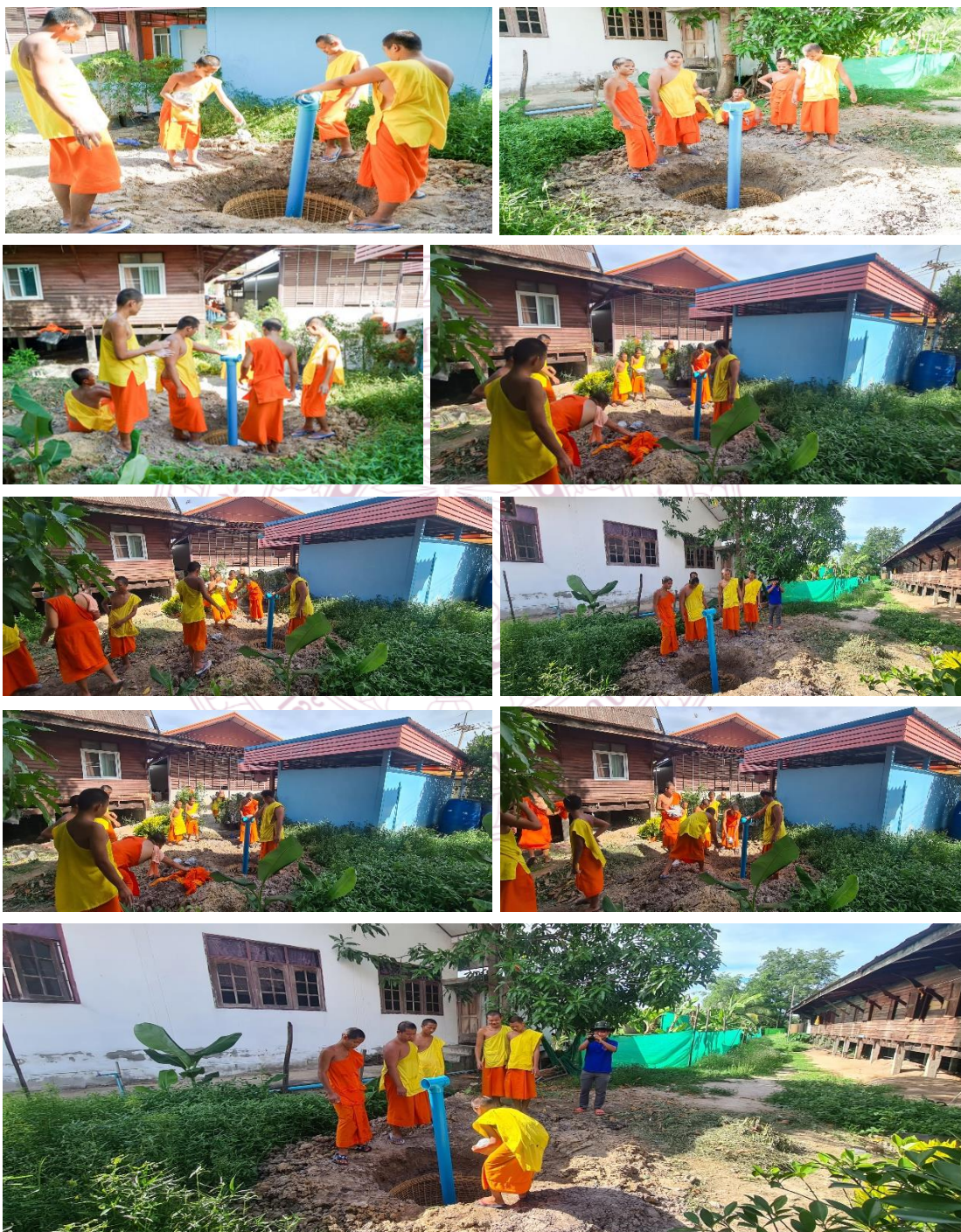
ภาพที่ ๔.๘ การจัดทำธนาคารน้ำใต้ดินแบบพอเพียงระบบปิด แบบคร้วเรือน บริเวณวัดหนองกระดุกเนื้อ
