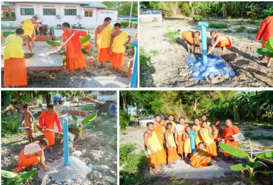
ภาพกิจกรรม การจัดทำธนาคารน้ำใต้ดินแบบพอเพียงระบบปิด แบบครัวเรือน บ้านหนองกระดุกเนื้อ
