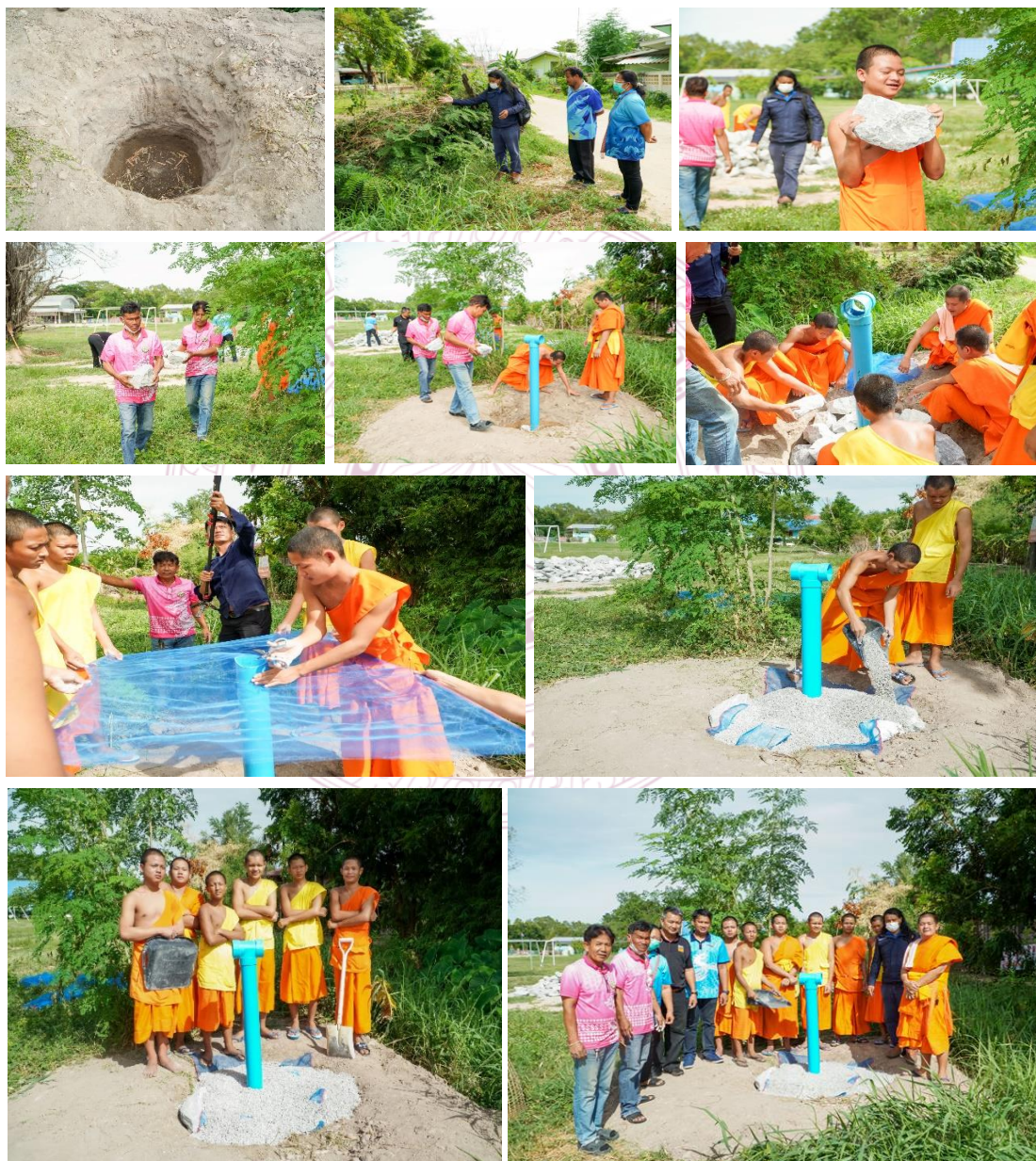
ภาพที่ ๔.๗ การจัดทำธนาคารน้ำใต้ดินแบบพอเพียงระบบปิด แบบคร้วเรือน บริเวณปากคลองกลางชุมชน บ้านหนองกระดุกเนื้อ
