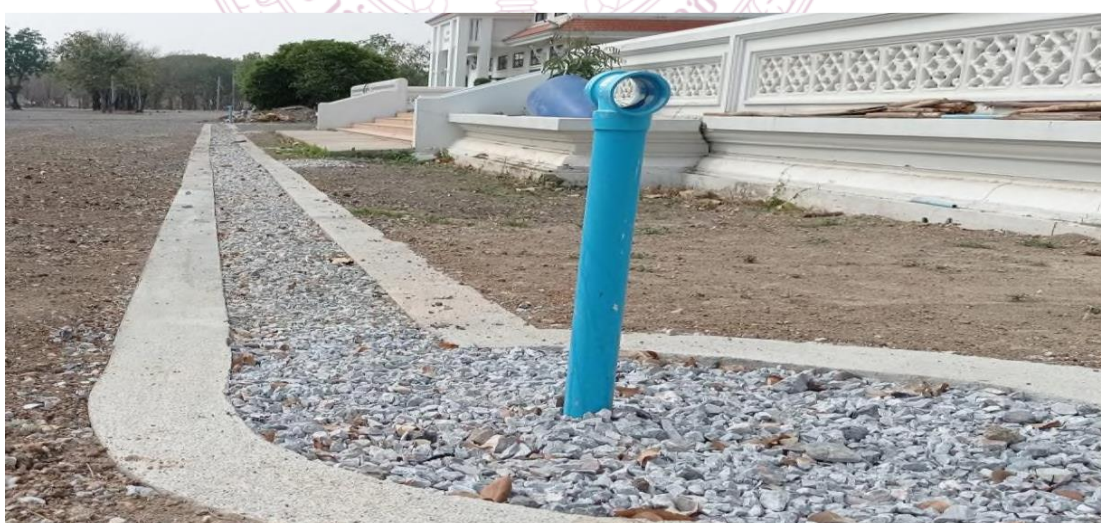
แผนภาพที่ ๒.๗ ระบบธนาคารน้ำใต้ดินระบบปิดชนิดร่องไรท่อ ๓๕
