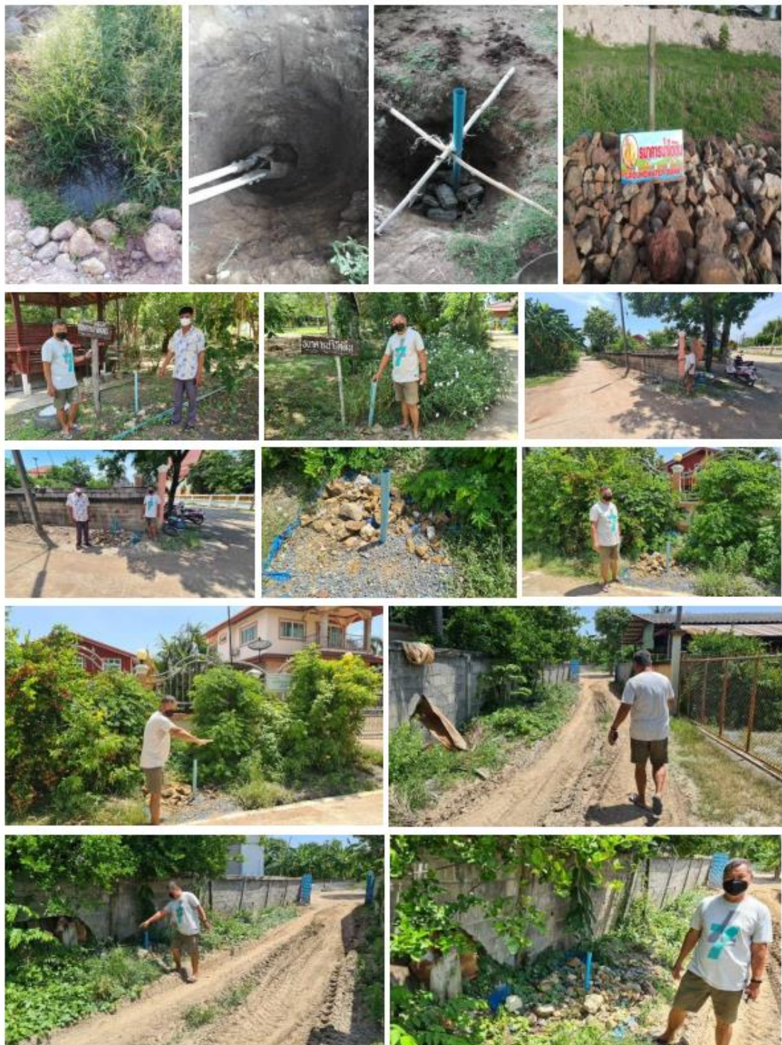
ภาพกิจกรรม การจัดทำธนาคารน้ำใต้ดินแบบพอเพียงระบบปิด แบบครัวเรือน บ้านหัวถนนกลางในจุดต่าง ๆ ที่มีปัญหาน้ำท่วมขังในชุมชนและภายในวัดหัวถนนกลาง
