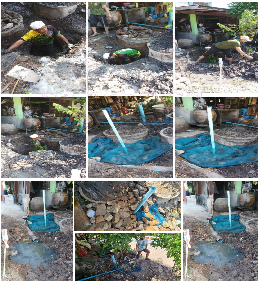
ภาพที่ ๔.๑๑ การจัดทำธนาคารน้ำใต้ดินแบบพอเพียงระบบปิดบริเวณร้านกล้วยเดี่ยวบ้านหัวถนนกลาง
