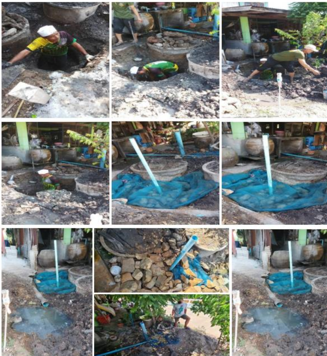
ภาพกิจกรรม การจัดทำธนาคารน้ำใต้ดินแบบพอเพียงระบบปิดบริเวณร้านกล้วยเตี๋ยบ้านหัวถนนกลาง
