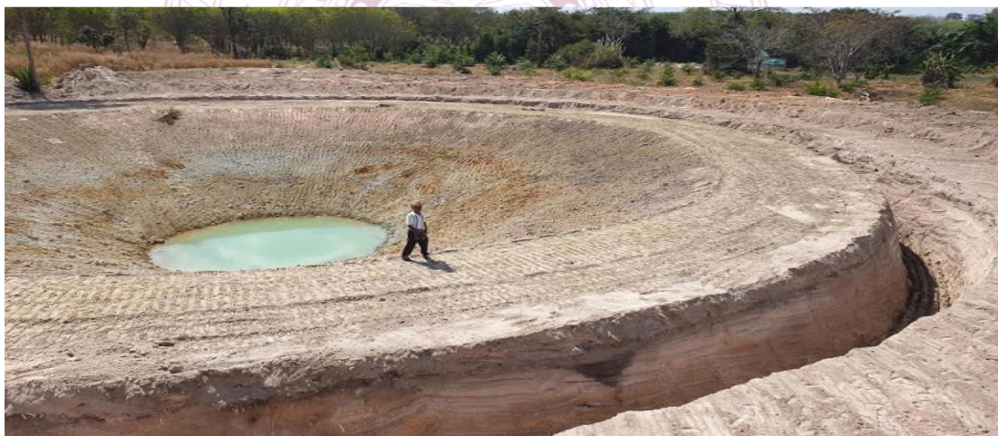
แผนภาพที่ ๒.๕ ระบบธนาคารน้ำใต้ดินระบบเปิดกรณีแหล่งน้ำสาธารณะ ๓๓
