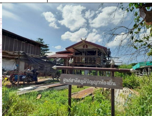
ความคืบหน้าของการก่อสร้าง วันที่ ๑๘ มิถุนายน ๒๕๖๕ ที่ได้มีการก่อสร้าง เป็นรูปเป็นร่าง
