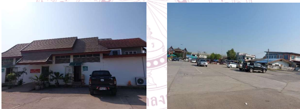
ภาพประกอบที่ ๔.๕๐ ห้องน้ำสาธารณะและลานจอดรถ
